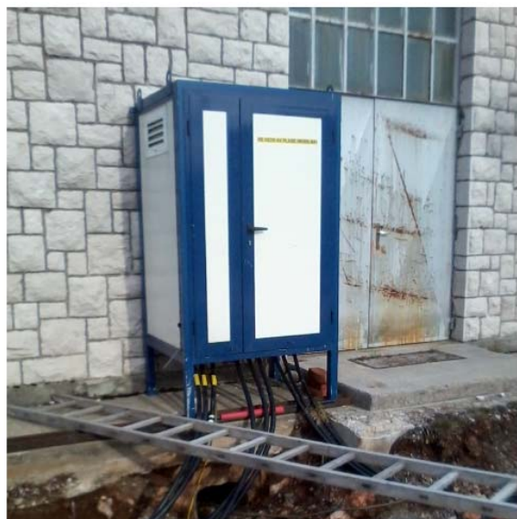
Slika 3. Kućište s privremenim 10(20) kV postrojenjem i jednopolna shema RS Plase
