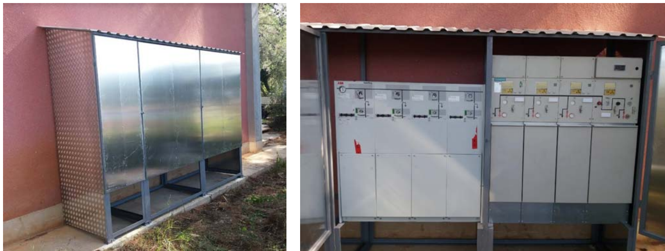
Slika 6. Kućište s privremenim 10(20) kV postrojenjem TS Cres
